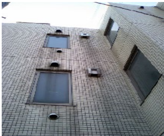
・タイル外壁 汚ダレ除去・除菌洗浄
