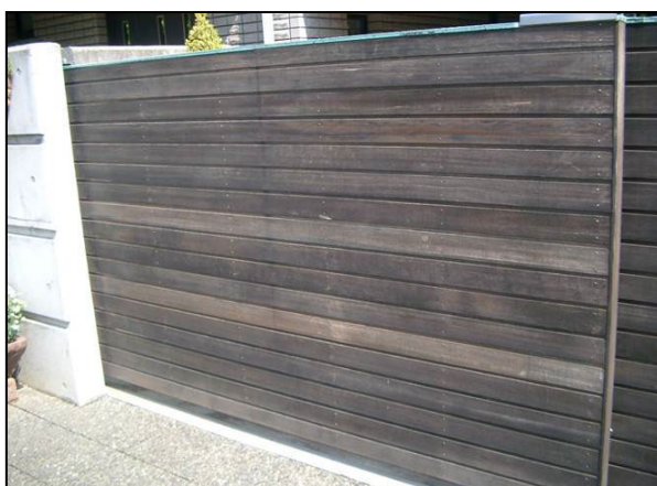
・門扉 除菌洗浄
