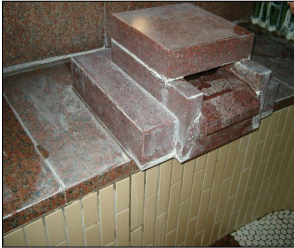
・浴槽タイル 錆び除去・除菌洗浄
