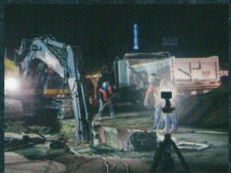
夜間の建設工事現場
