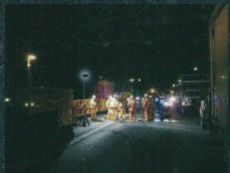
夜間の道路工事現場
