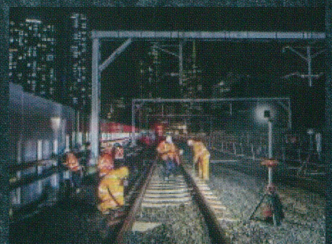
夜間の鉄道工事現場
