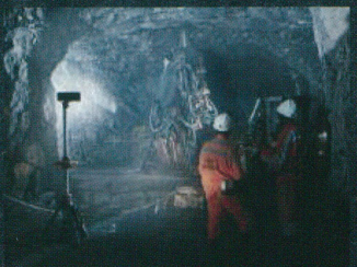
トンネル工事の照明
