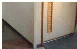
コーナープロテクターを 上から差し込んで完了。
