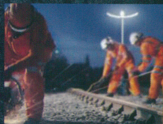
夜間の鉄道保守工事
