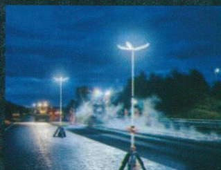
夜間の道路工事
